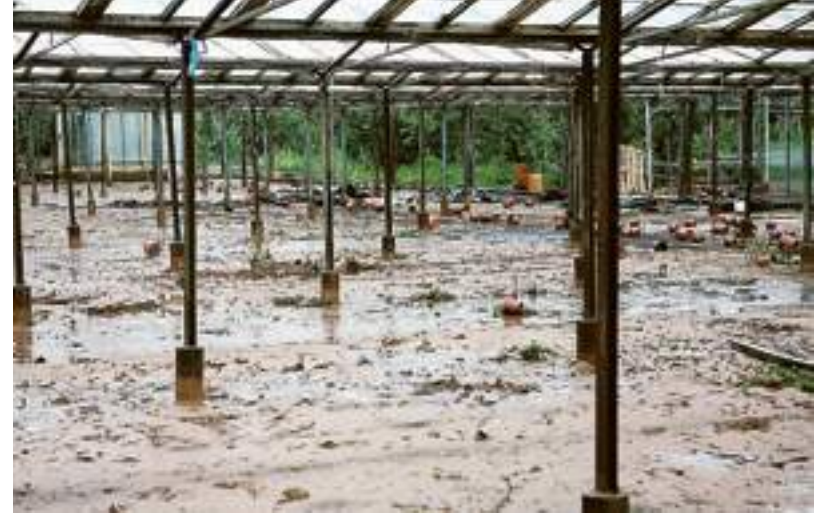
Una serra devastata dall'alluvione del 2006
